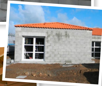
Avancement des travaux au 05 mai
