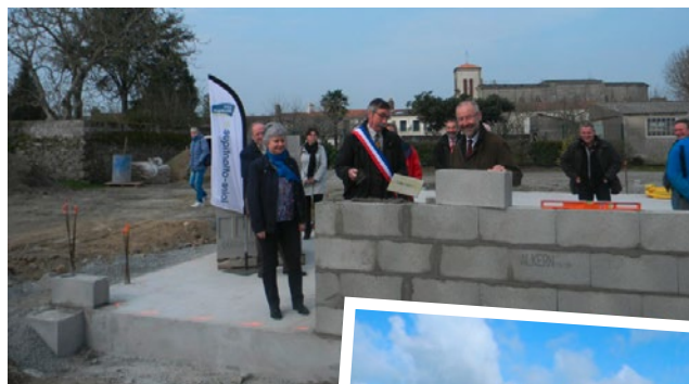
Pose 1 ère pierre extension restaurant scolaire
